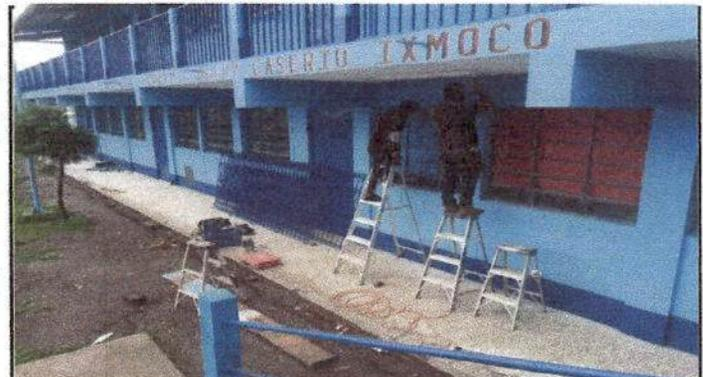
Foto 4: la colocación de balcones de metal en ventanas, parte frontal del edificio
